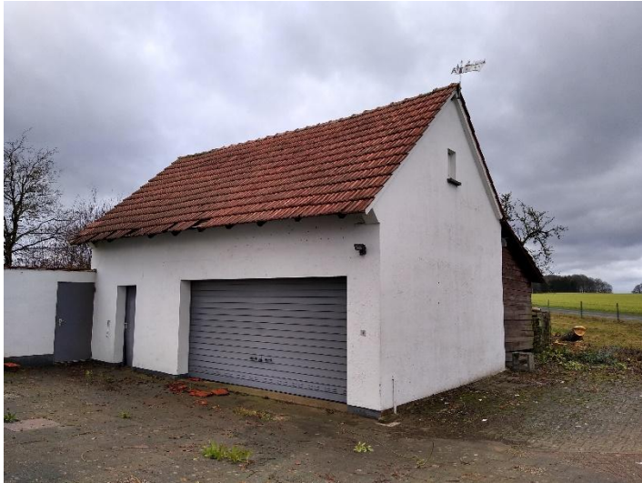
Abbildung 2: Blick auf die Garage nach Westen
